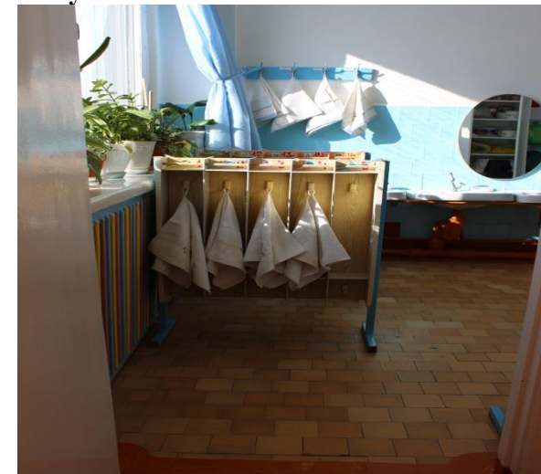
5. Туалетная комната 2 этаж
